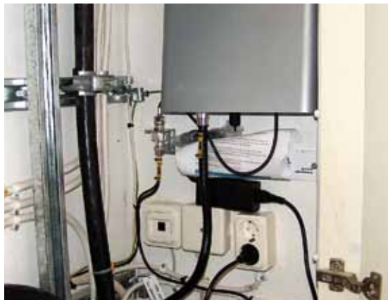
Repeatern under taket är en ETSI-godkänd DMR 62I från svenska MIC Nordic, som förstärker en 3g-signal i bandet 1920-1980 och 2110-2170 MHz mellan 50 och 80 dB. Den drar cirka 35 watt och klarar -25 graders temperatur. Den kan alltså sitta i en kall vindsskrubb. Den grova koaxialkabeln går ned i huset medan den tunna går ut till utomhusantennen.
