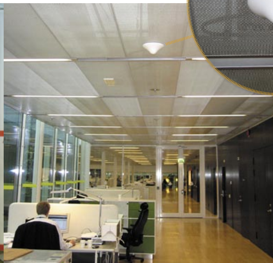
Totalt har 80 små rundstrålande antenner skruvats upp runt om i OMX lokaler. Open Antenna System använder ett och samma nät för gsm, 3g och wlan.
